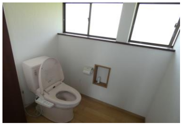
1階 トイレ①
