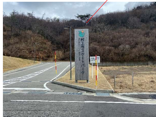
敷地入口（県道入口）H3.7m×W1.0m
