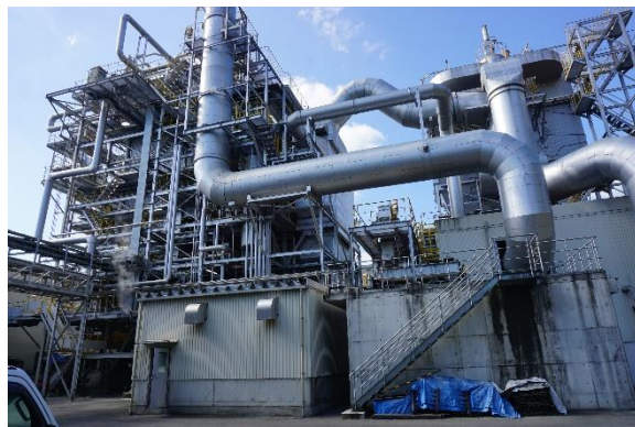
真庭バイオマス発電所
