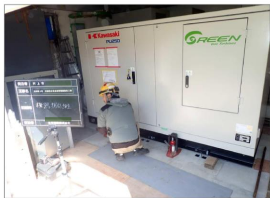
大雨災害で被災した発電装置の更新状況
