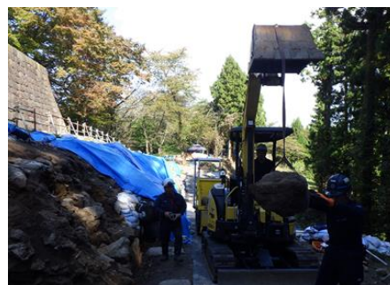
令和6年度の村上城跡石垣解体工事
