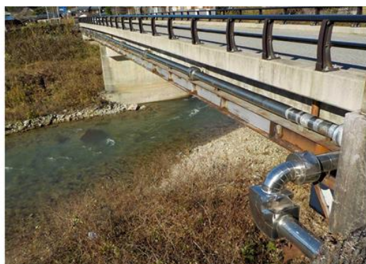
老朽化した水管橋の点検実施
