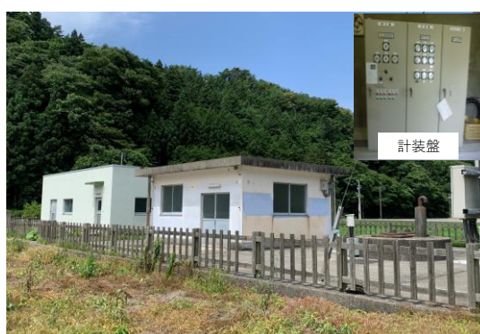
更新する山北地区遠方監視設備
