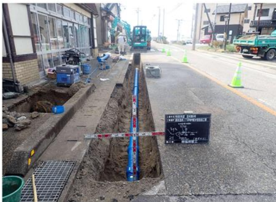
水道管路更新工事
