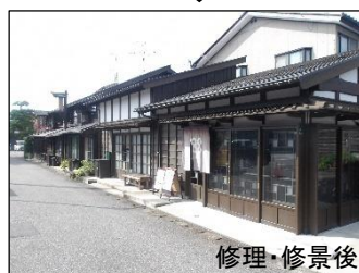
修理・修景後
