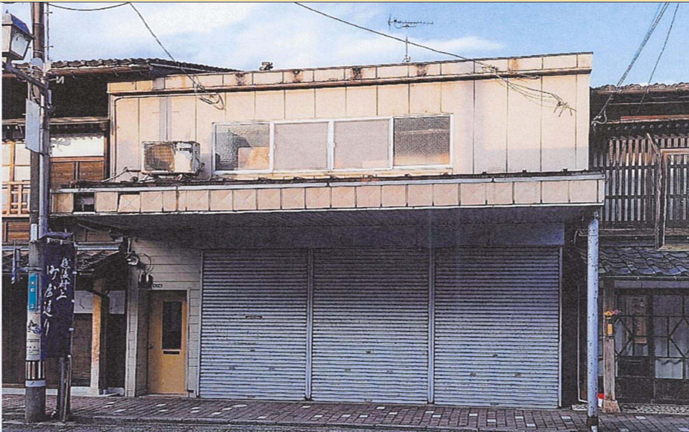
旧渡邊家住宅修理前
