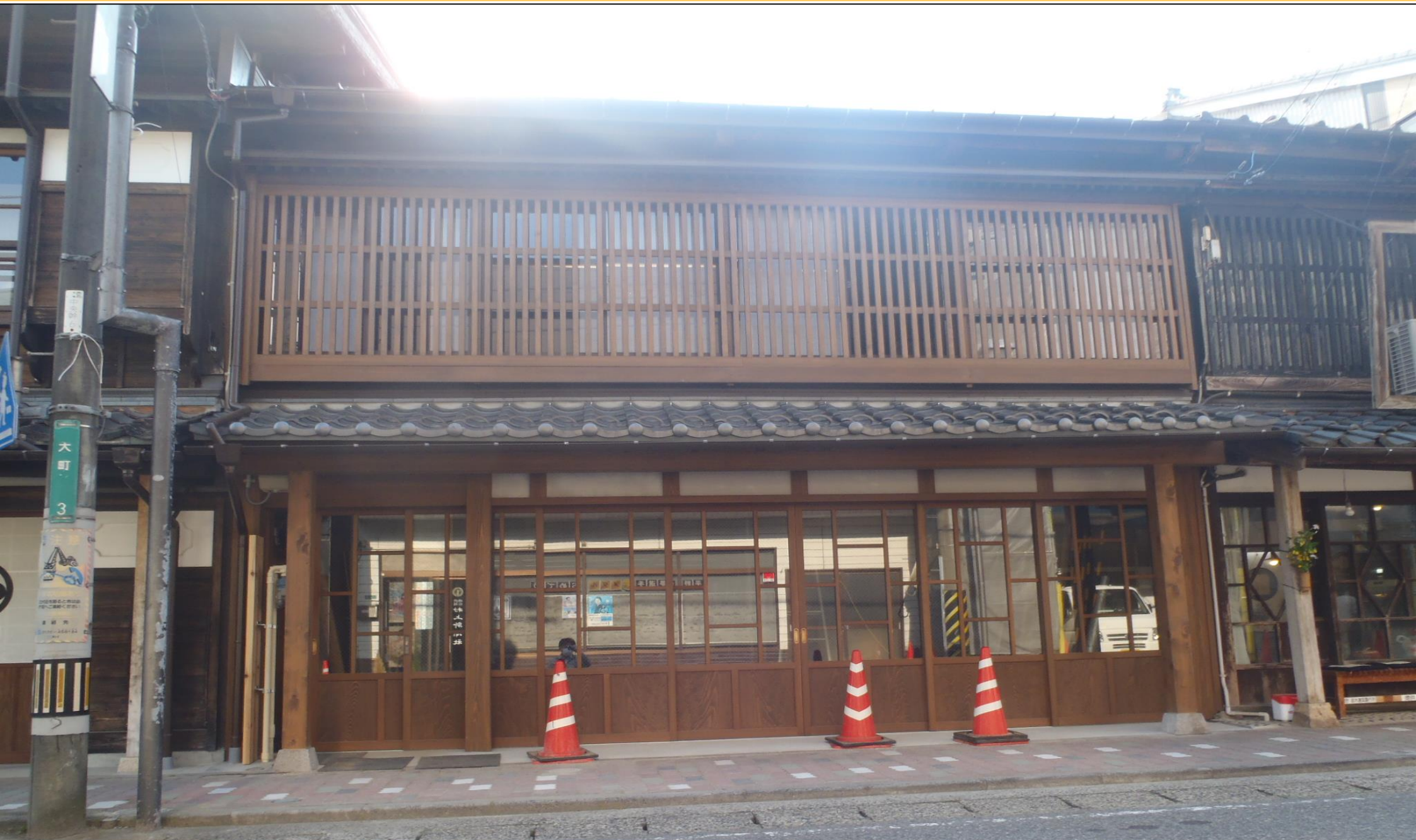
旧渡邊家住宅修理後
