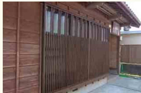
完成した出格子窓
