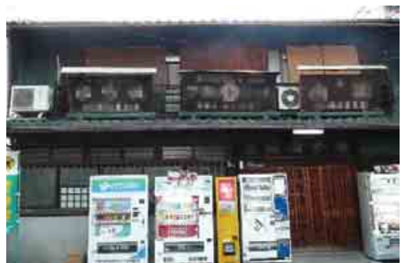
景観を損ねる自動販売機や室外機
