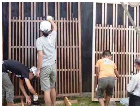
住民による出格子製作の様子（塩谷地区）
