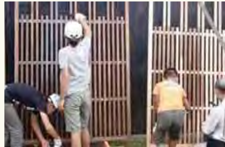
住民の手作業による出格子製作
