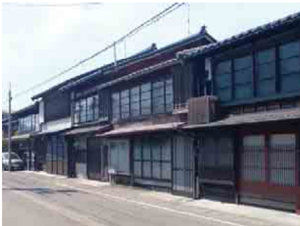
間口が狭く奥行きが深い切妻造・平入の町家
