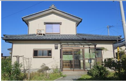
外観(左下部分に駐車スペースあり)
