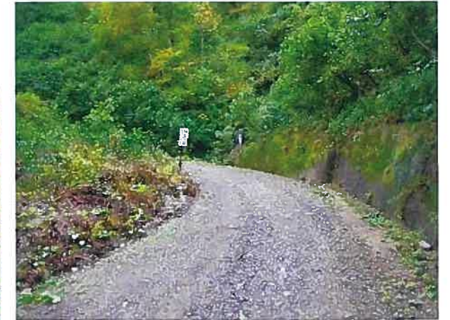
シミズ沢付近未舗装部 (鶴岡市)
