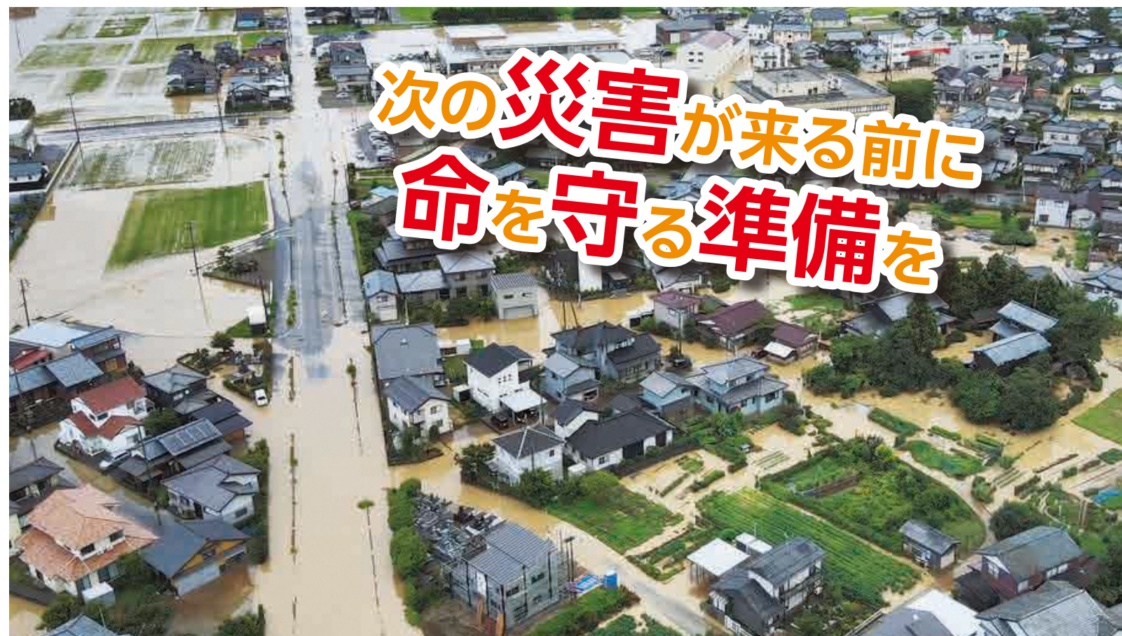
▲令和4年8月豪雨の被害(荒川支所周辺)
