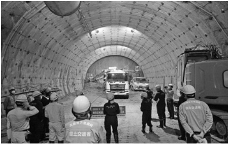
鋼管ボルト数が難工事の証（11号トンネル）
