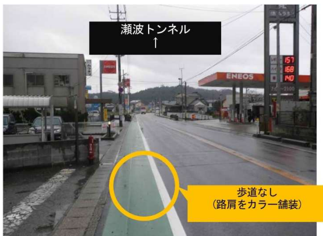
【国道 345 号における歩道未整備箇所】
