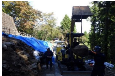
▲黒門跡石垣修復工事
