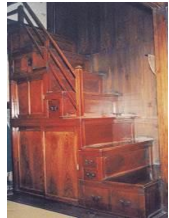
図 町家内部の箱階段
