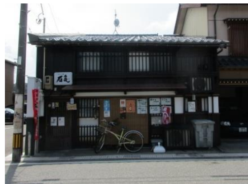
図 やすらぎ処石亀（旧八藤後家住宅）
