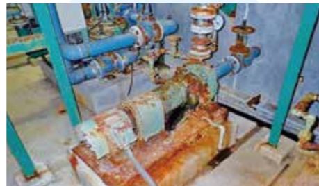
老朽化した処理場設備
