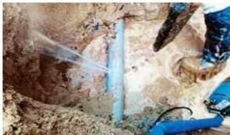
水道管の漏水
