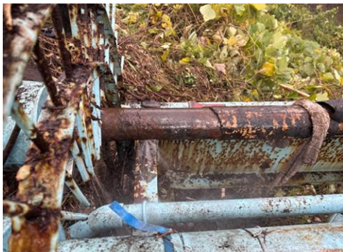
水管橋点検により発見した漏水状況
