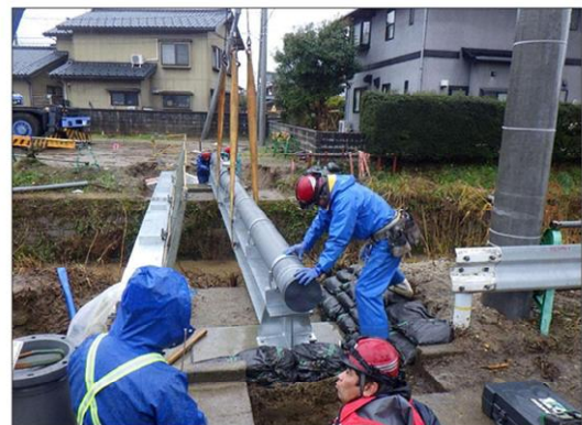
災害復旧工事による水道管の仮設状況
