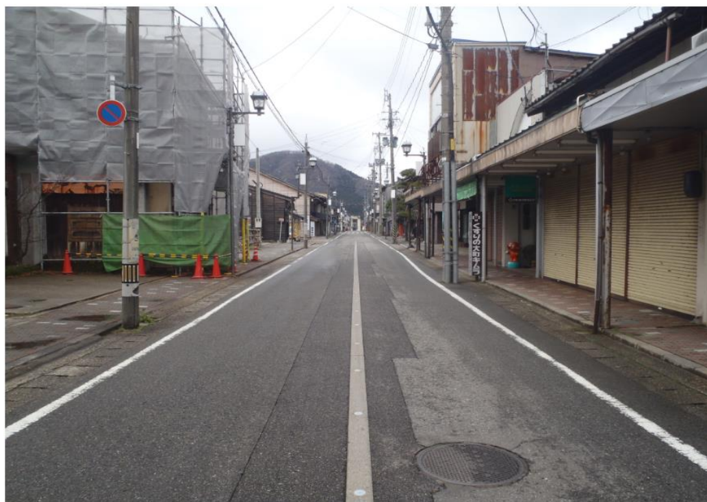
(修理・修景前)
