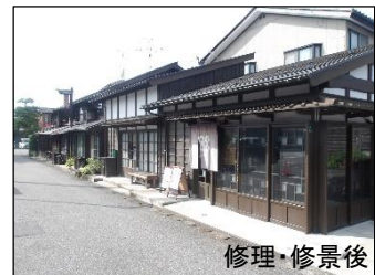
修理・修景後
