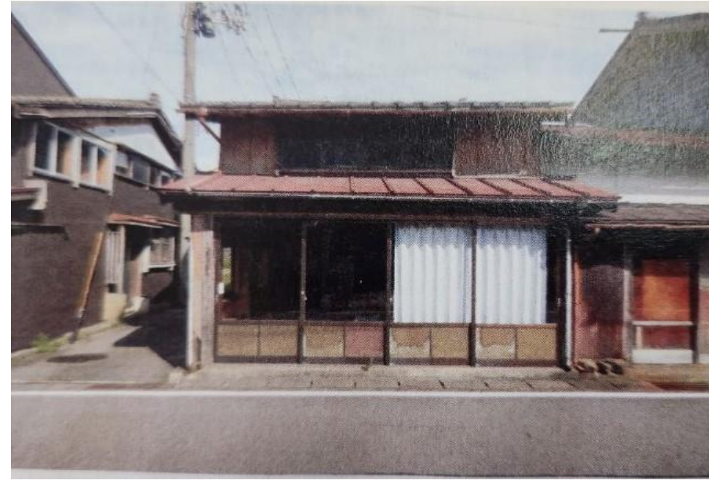
旧小和田板金(南棟)
