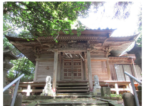
図 管堅八幡宮社殿
