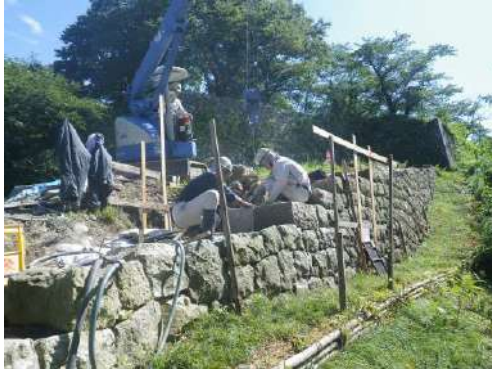
図 村上城跡の石垣の修復
