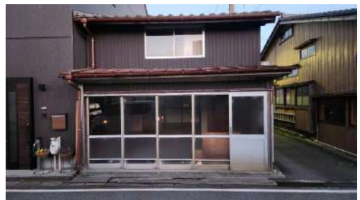
図 旧小和田板金 北棟
