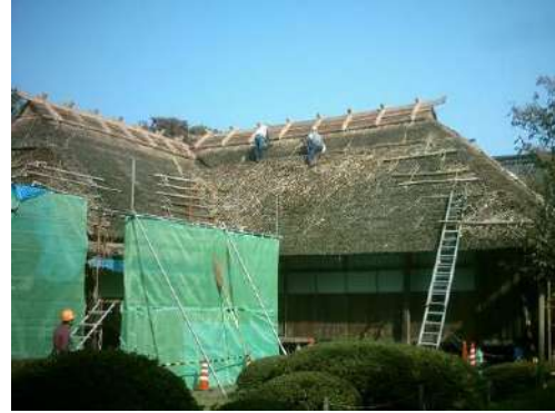
図 若林家住宅の茅葺き屋根の修復
