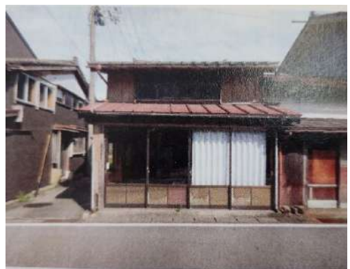
図 旧小和田板金 南棟
