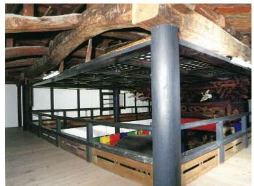
図 浄念寺本堂二階の廻廊
