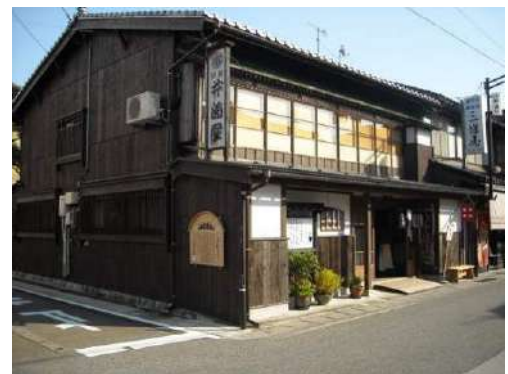
図 千年鮭井筒屋（井筒屋（鳥山家住宅））
