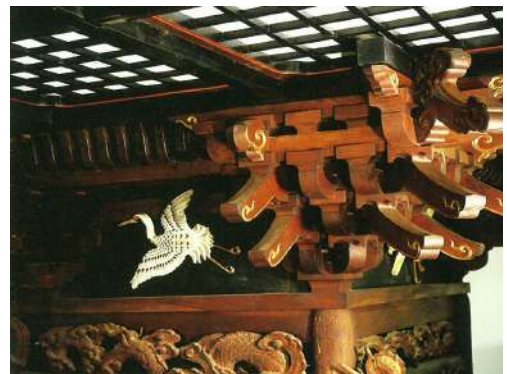
図 浄念寺本堂内部の須弥壇の組物
