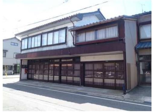
図 旧共立鉄工所（片野家住宅）
