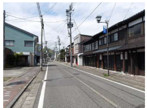
図 現在の村上地区大町の町並み
