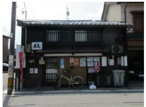
図 やすらぎ処石亀（旧八藤後家住宅）
