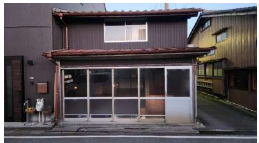
図 旧小和田板金 北棟
