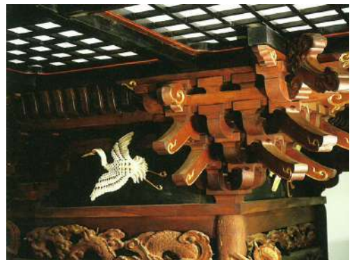
図 浄念寺本堂内部の須弥壇の組物
