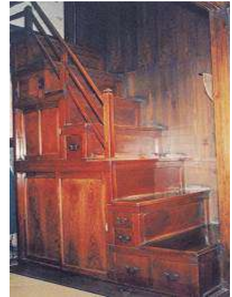
図 町家内部の箱階段
