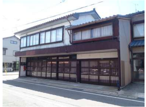
図 旧共立鉄工所（片野家住宅）
