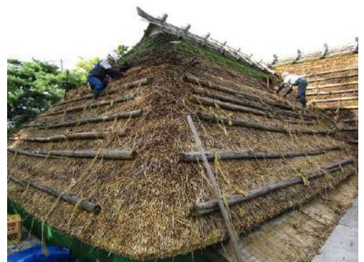
図 若林家住宅茅葺屋根葺き替え作業
