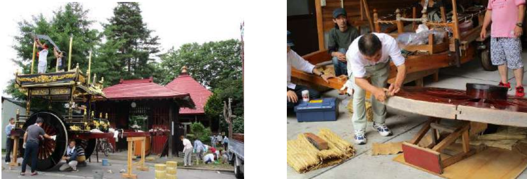
図 村上まつりの屋台組み立てと屋台車輪の修理
