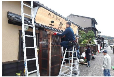
(写真左：九品仏を加えてリニューアルしたスタンプラリー、 写真右：イルミネーション設置作業の様子)
