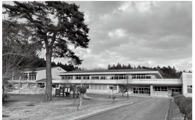
小川小学校と統合し、改修工事が行われる朝日みどり小学校
