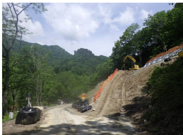
災害復旧工事状況(R4災 13.0kp)
