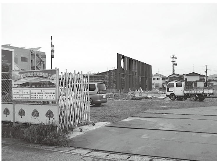
「あらかわ保育園」の建設現場
