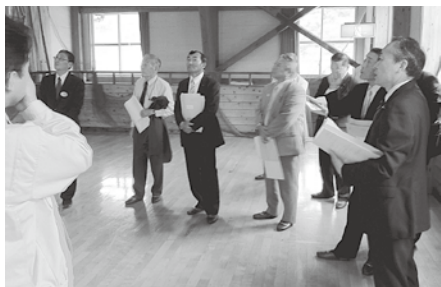
体育館の天井部梁等の状況を調査 (山北中学校)
