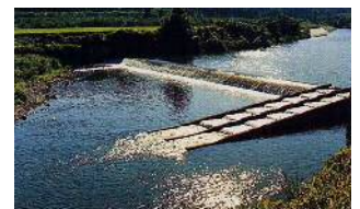
頭首工における魚道の設置例
