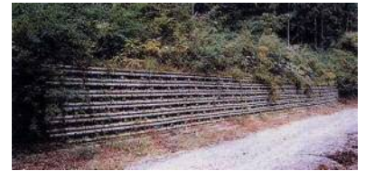
間伐材を木製ブロックとして利用した例
