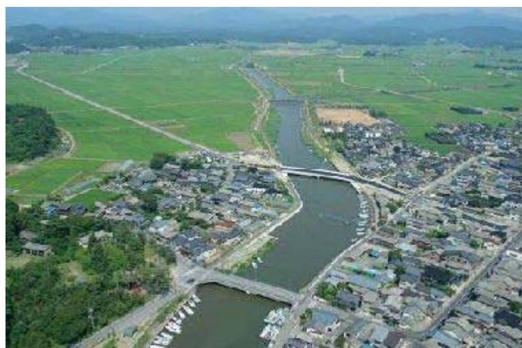
改修事業により整備された石川（写真提供：地域整備部）
