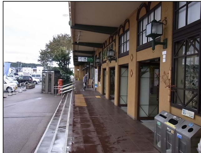
図. 駅舎の出入り口付近→
