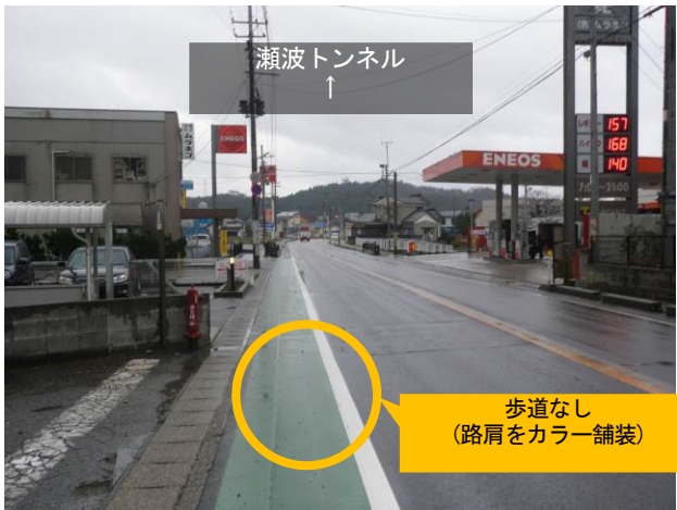
【国道 345 号における歩道未整備箇所】
