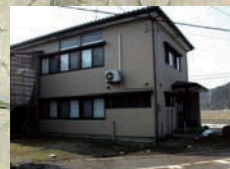
松沢多目的研修センター
