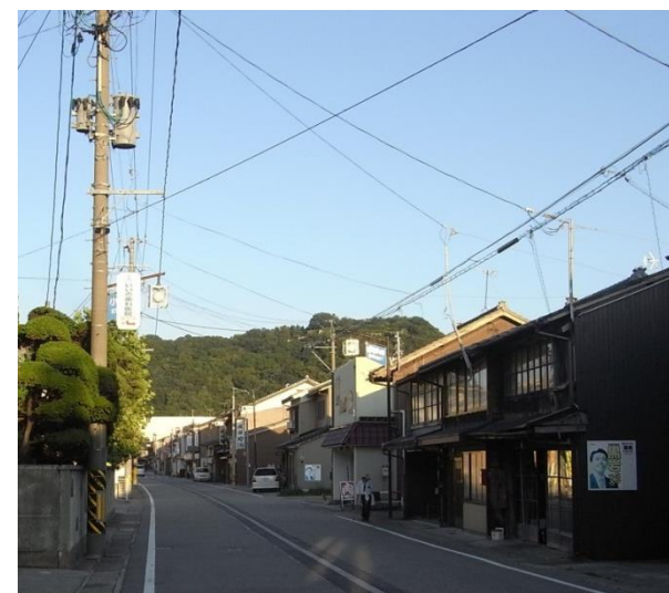
歴史的町並みを阻害する 電柱・電線
