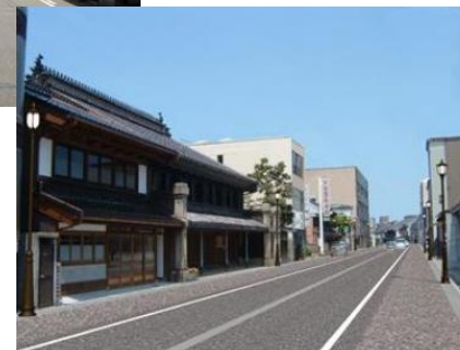
電線類の地中化と道路修景
