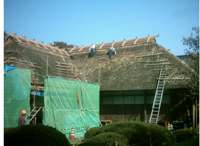
若林家住宅の屋根の修復
