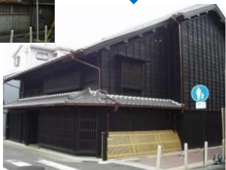
建築物の修景による町並み形成
