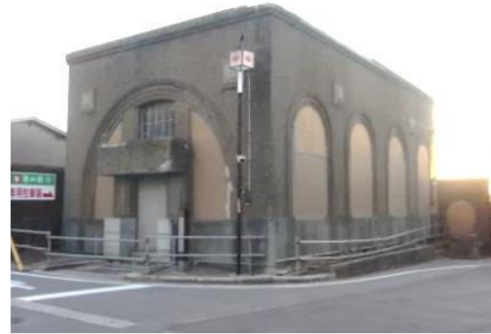
喪失の危機にある未指定の建造物
