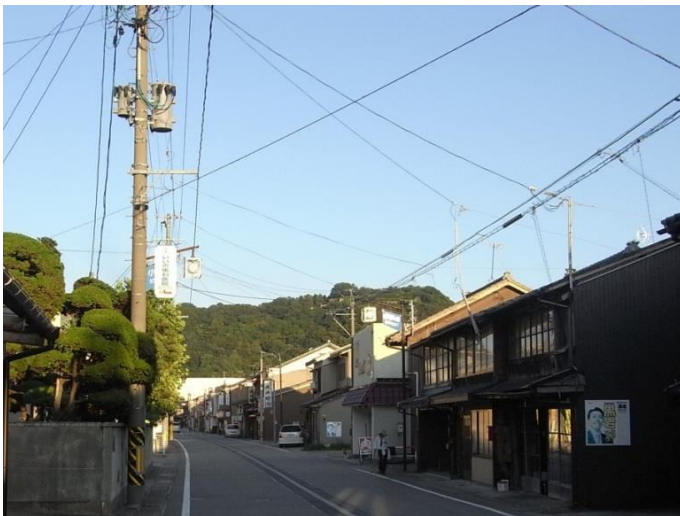
町並み景観を阻害する電柱・電線
