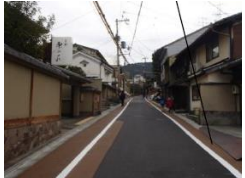
整備後(路肩のカラー舗装)
