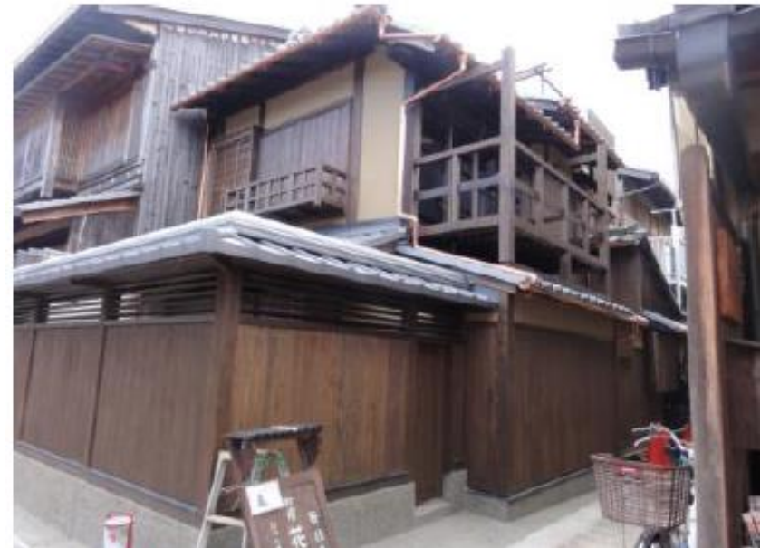
修理後(外壁修理、塀修景)
