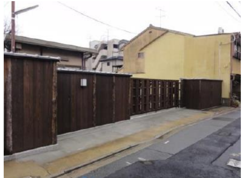
修理後(塀修景)
