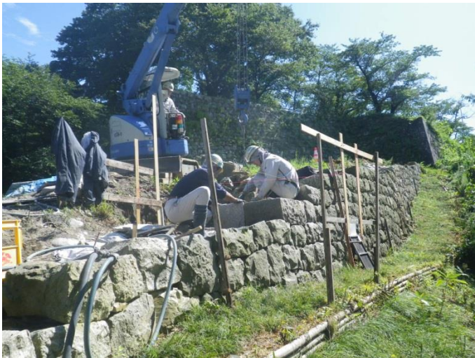
村上城跡の石垣の修復
