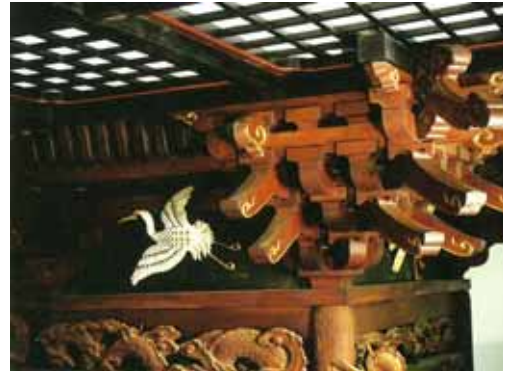
図 浄念寺本堂内部の須弥壇の組物
