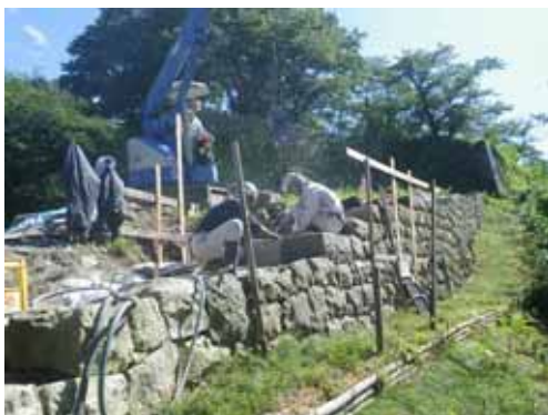
図 村上天跡の石垣の修復
