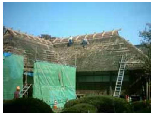
図 若林家住宅の茅葺き屋根の修復
