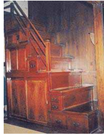
図 町家内部の箱階段
