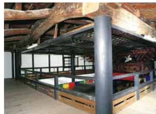
図 浄念寺本堂二階の廻廊
