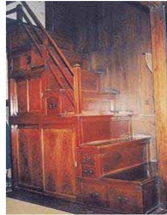
図 町家内部の箱階段
