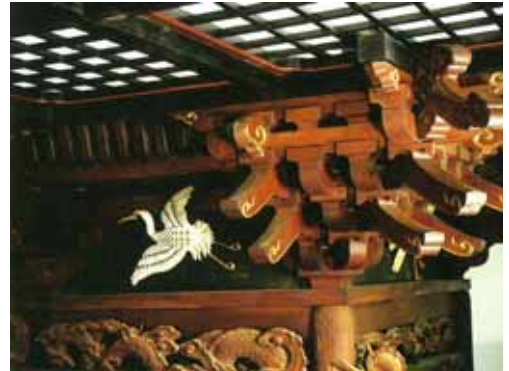
図 浄念寺本堂内部の須弥壇の組物
