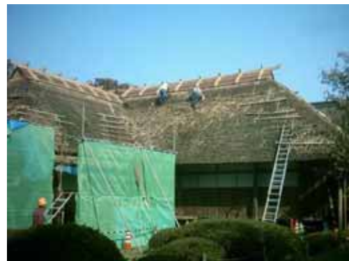
図 若林家住宅の茅葺き屋根の修復
