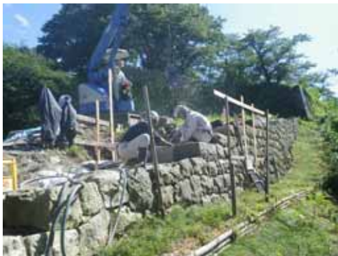
図 村上天跡の石垣の修復
