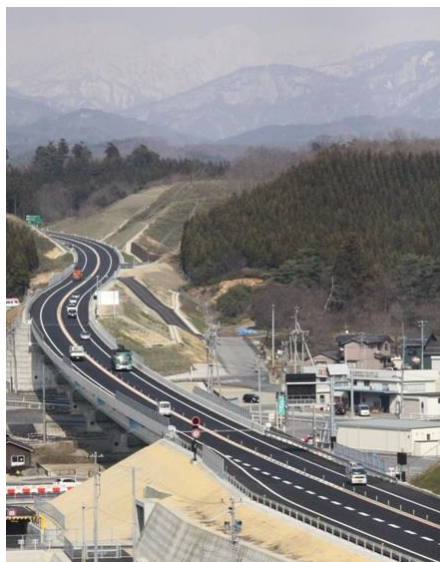
日本海沿岸東北自動車道
