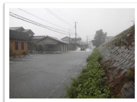
市道海員学校線冠水状況
