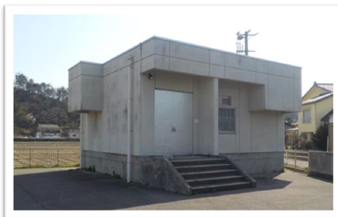
瀬波第2中継ポンプ場
