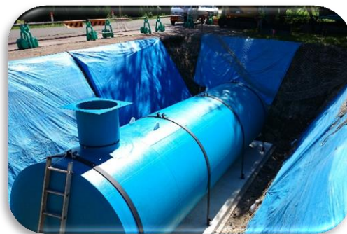
埋設型防火水槽の設置（H28年度熊登地内）
