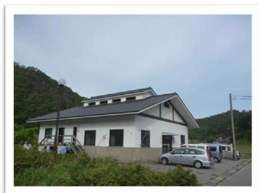
越沢処理区農業集落排水処理施設
