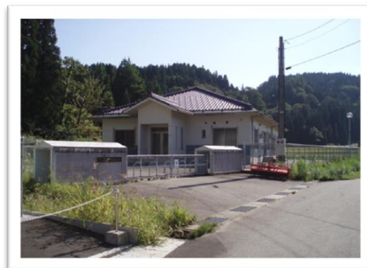
高根地区農業集落排水処理施設
