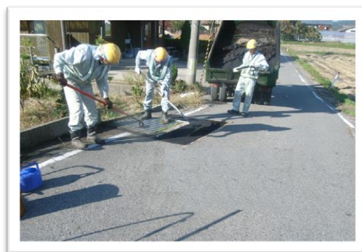
舗装修繕の状況
