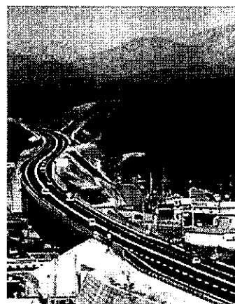
日本海沿岸東北自動車道
