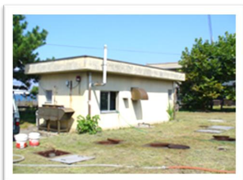
中浜処理区農業集落排水処理施設
