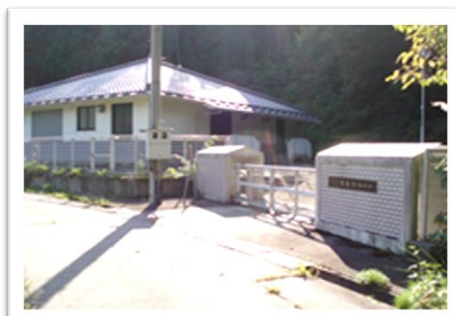
蒲萄地区農業集落排水処理施設
