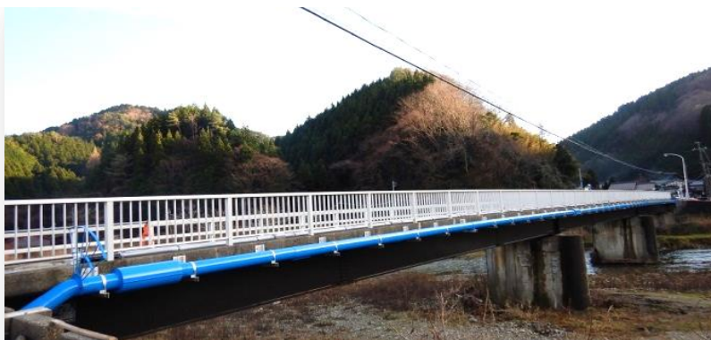
大谷沢橋水管橋
