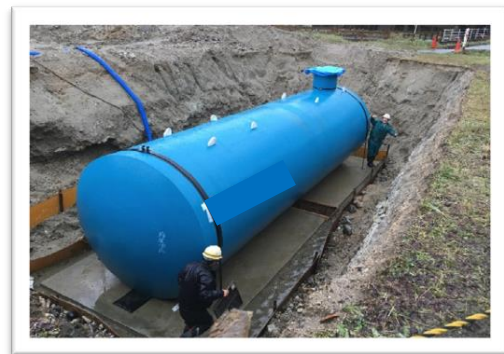
埋設型防火水槽の設置（H29年度府屋地内）
