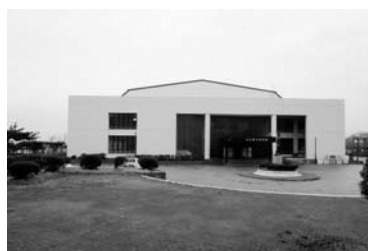
▲屋根・外壁を全面改修
