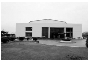
▲屋根・外壁を全面改修
