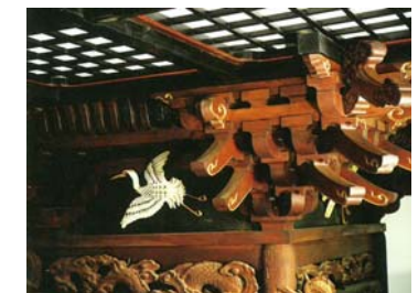
図 浄念寺本堂内部の須弥壇の組物
