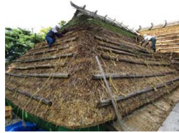
図 若林家住宅茅葺屋根葺き替え作業
