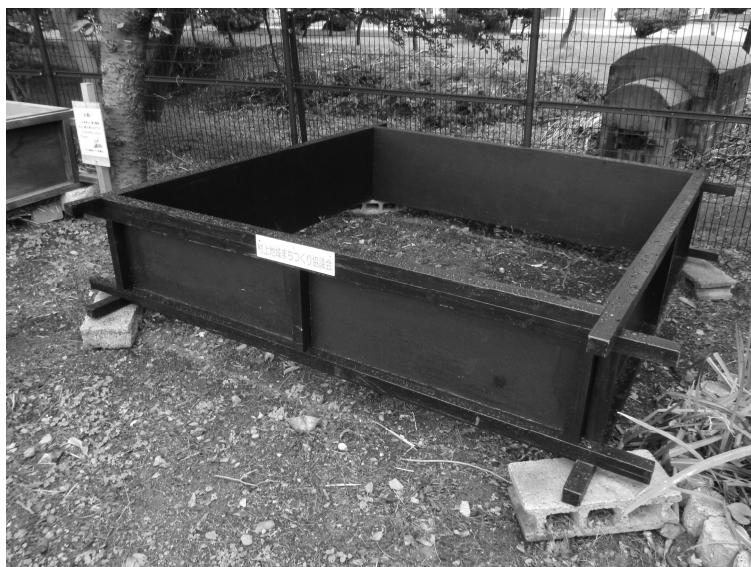
更新した堆肥化木枠
