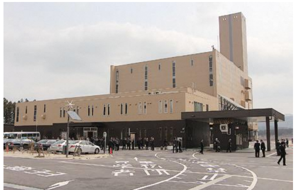
▲エコパークむらかみ稼働 (平成27年3月)
