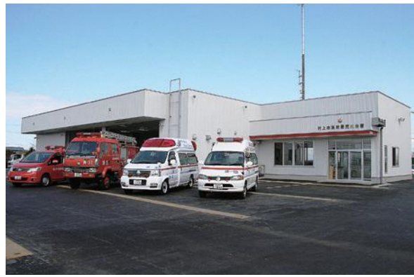
▲村上市消防署荒川分署竣工 (平成21年3月)
