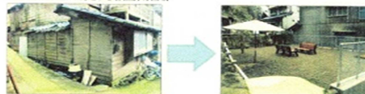
【福井県越前町】老朽化した空き家住宅を除却し、ポケットパークとして活用
