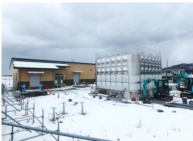
建設中の荒島浄水場
