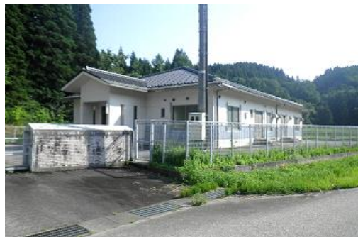
高根地区農業集落排水処理施設
