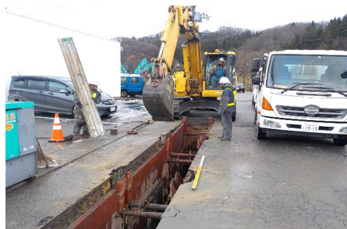
管渠布設工事
