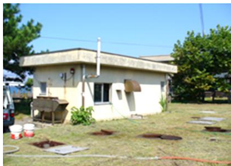
中浜地区農業集落排水処理施設
