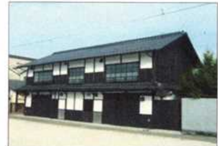
【広島県庄原市】 長屋住宅を交流・展示施設として活用
