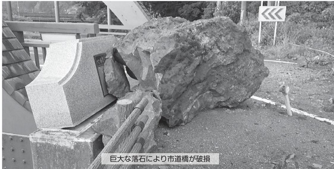
巨大な落石により市道橋が破損
