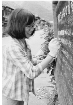
▲小俣宿まちなみ看板修繕中
